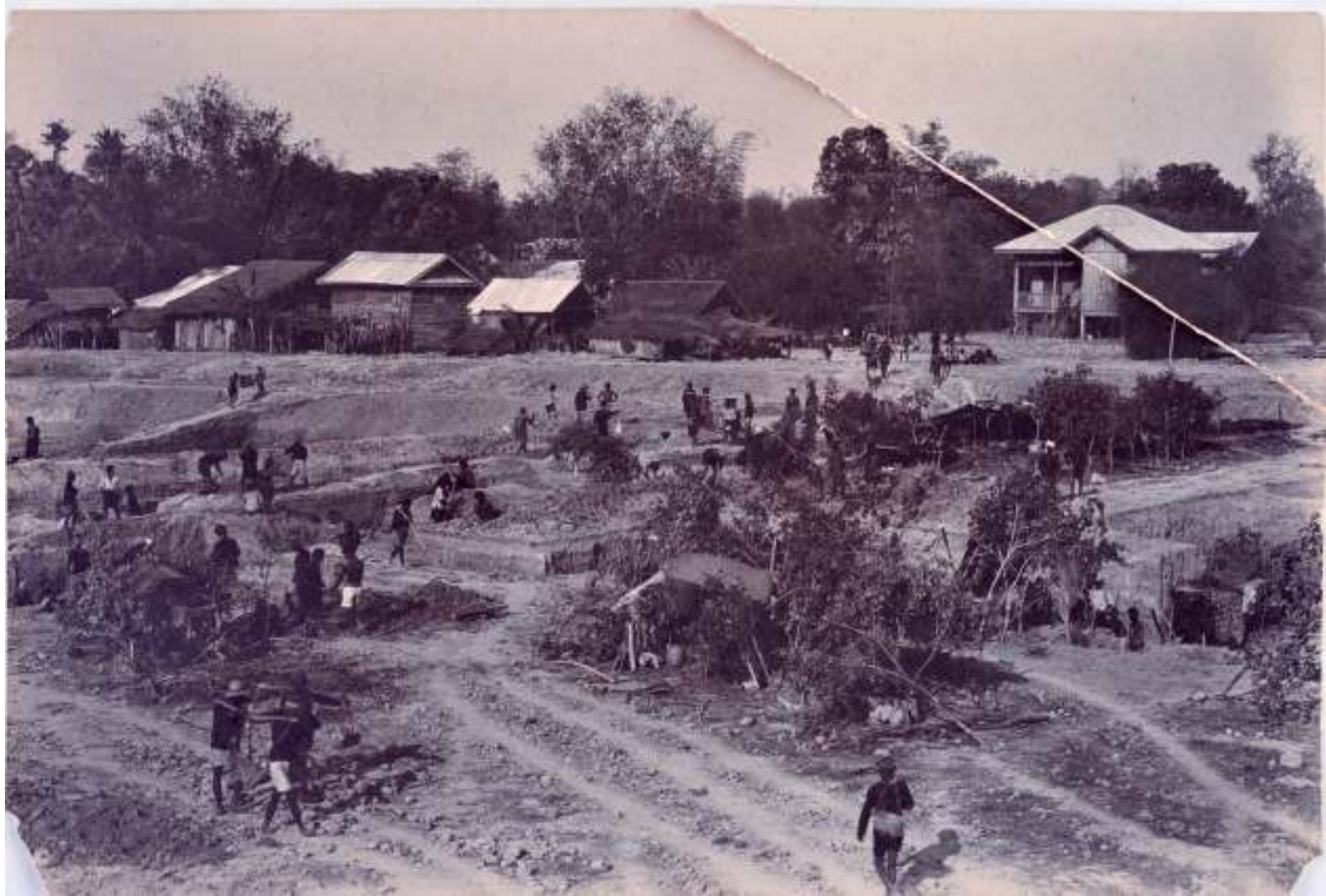
บึงพระลานชัยกำลังขุด Bung Phra Lan Chai under construction.
