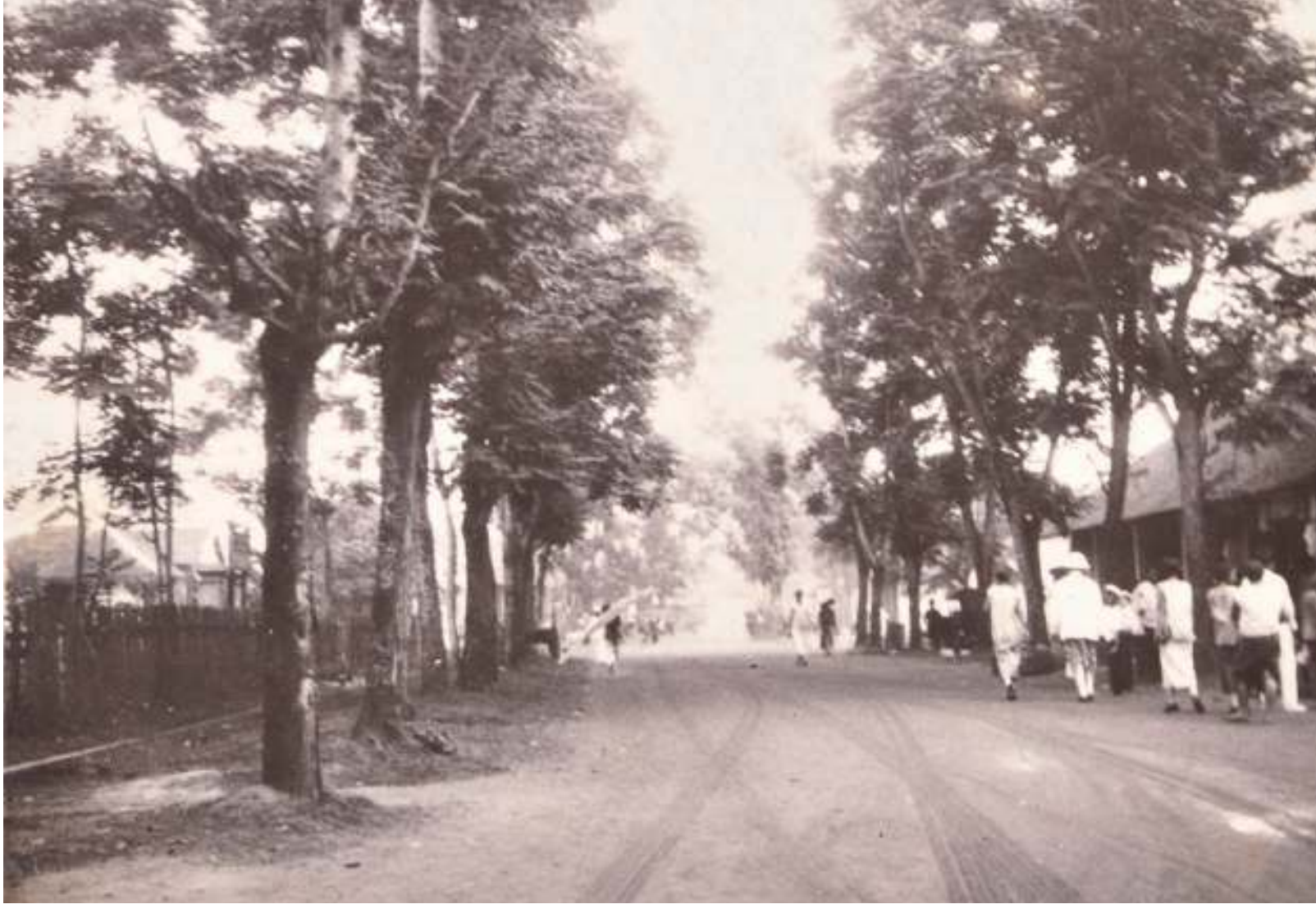
ไม่มีคำบรรยายภาพมาแต่เดิม ถนนในอำเภอธาตุพนม จังหวัดนครพนม
