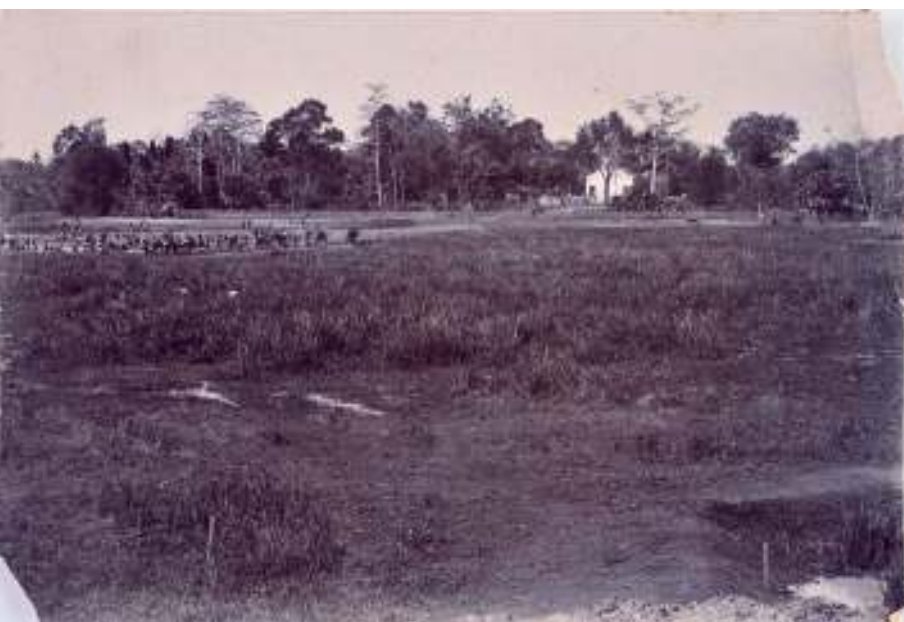
บึงพระลานชัยทางหน้าวัด บึงกำลังเริ่มขุด The beginning of the construction of Bung Phra Lan Chai, in front of a Buddhist monastery.
