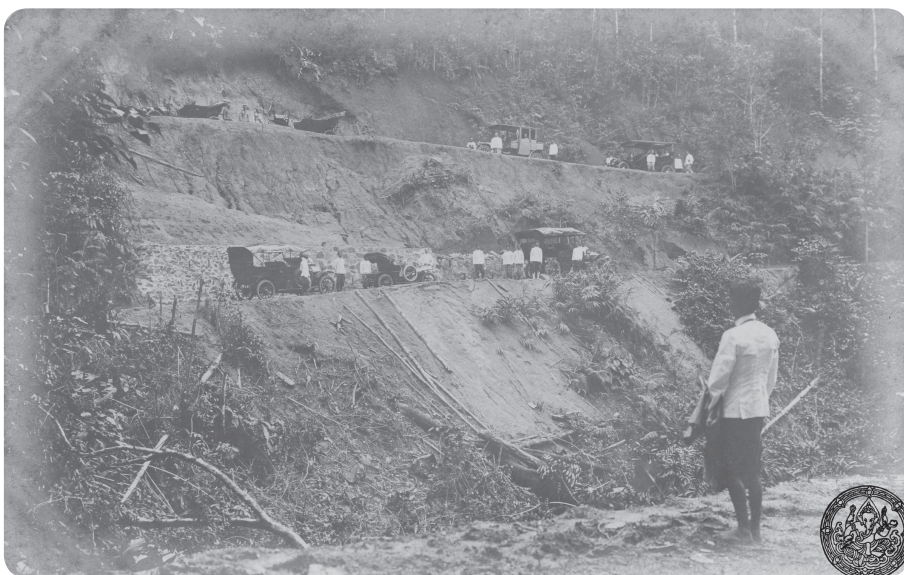
เสด็จตรวจการทำงานสร้างทางรถไฟสายใต้
